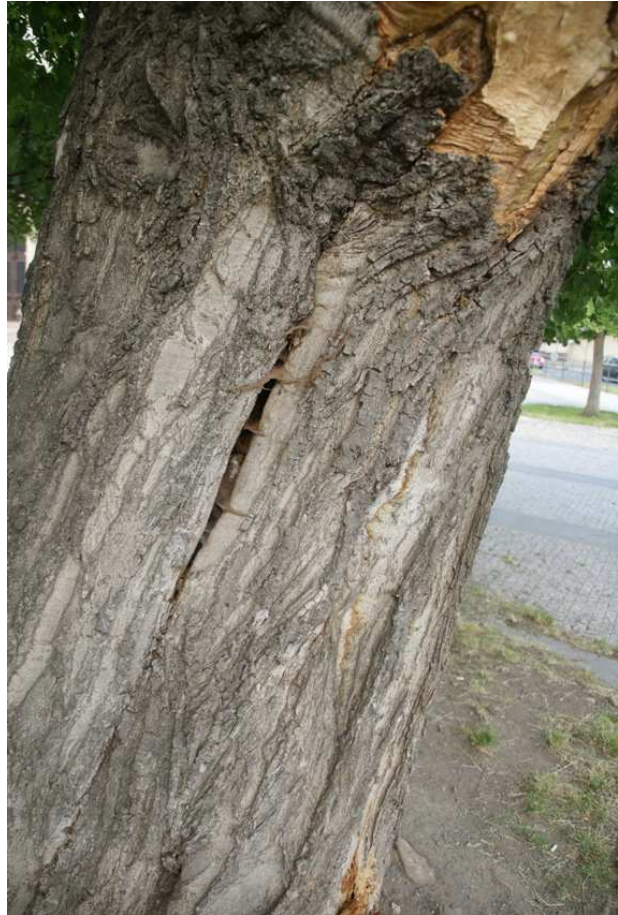
prasklina kmene, rozsáhlá dutina s hnilobou
