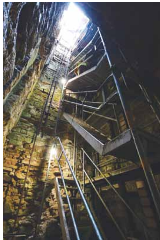
Opravy v bývalém pivovaru probíhají také v 16 metru hlubokých sklepeních se zaměřením na zajištění statiky.
