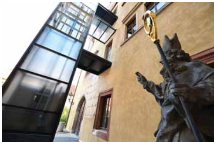
Nový výtah je situován ve dvoře radnice na Mírovém náměstí, výstavba trvala půl roku. Foto: Radim Tuček
